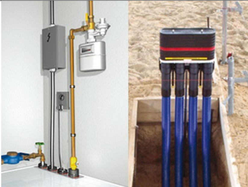
Abbildung: Hausanschlussraum ohne Keller
