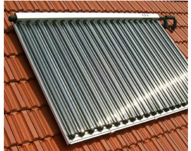
Die Solarthermie erweist sich als wertvolle Ergänzung in der GebäudewärmeverSORGUNG. Mit ihr wird Sonnenenergie in Wärme gewandelt. Hierfür werden Solarkollektoren genutzt, die Sonnenstrahlen absorbieren und so eine Wärmeträgerflüssigkeit erhitzen. Diese gibt die Wärme dann an den Heizkreislauf des Gebäudes ab. Besonders lohnenswert ist die Kombination einer Solarthermieanlage mit einem Pufferspeicher.
