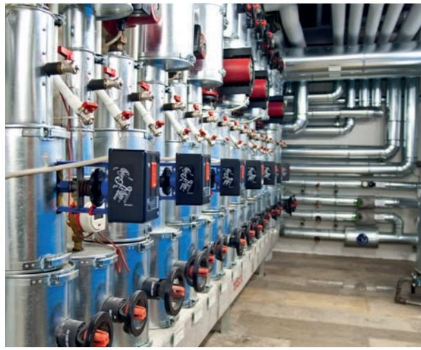
Eine sehr relevante Heizungsoption, die das neue GEG vor sieht, ist der Anschluss an ein Wärmenetz. In Wärmenetzen wird Wärme aus einer externen Wärmequelle über isolierte Rohrleitungen in das zu beheizende Gebäude transportiert. Dadurch entfällt der Bedarf einer eigenständigen Heizungsanlage, es wird lediglich die sogenannte Hausübergabestation benötigt, über die die Wärme in das Heizsystem des Gebäudes eingespeist wird.
